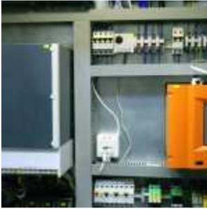
Die eigentliche Energieeinsparung ergibt sich aus der Anpassung der Pumpenaktivität und damit der Motordrehzahl an den tatsächlichen Leistungsbedarf. Da dieser in prozessbedingten Zykluspausen der hydraulischen Verbraucher null ist, kommt es somit automatisch zu einem Stillsetzen des Antriebes.
