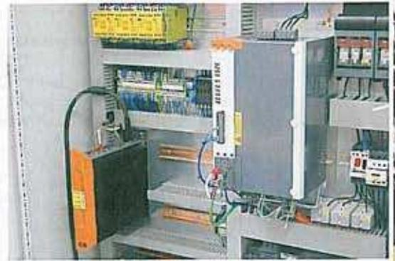
2: Der ACOPOS-Servoverstärker ist über POWERLINK mit dem Steuerrechner APC620 verbunden
