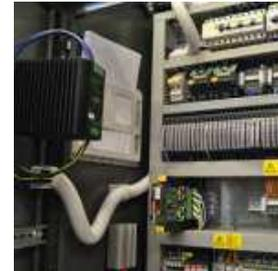
Herzstück der Stromversorgung für die Einrichtungen auf dem Parcours sind Schaltnetzteile der Murrelektronik-Baureihe Evolution (links im Bild). Wegen ihres sehr breiten Eingangsspannungsbereiches können sie weltweit einheitlich eingesetzt werden.
